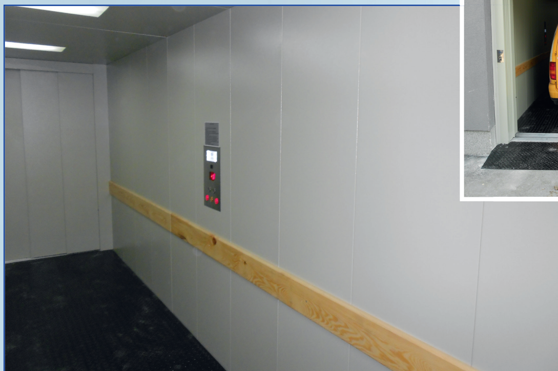
Zidovi plastifikacija, pod rebrasti lim, strop plastifikacija Plasticized walls, Corrugated sheet metal floor, Plasticized ceiling Wände Plastifizierung, Fussboden Rippenblech, Decke Plastifizierung
