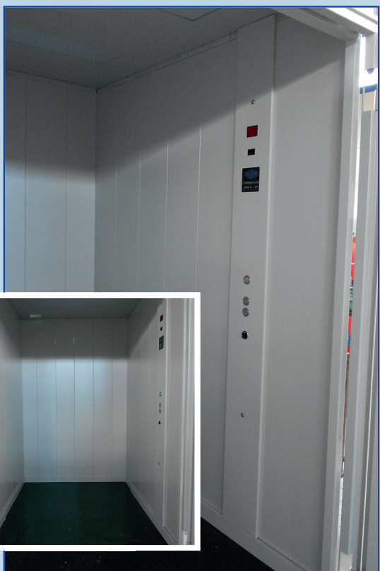
Zidovi plastifikacija, pod rebrasti lim, strop plastifikacija Plasticized walls, Corrugated sheet metal floor, Plasticized ceiling Wände Plastifizierung, Fussboden Rippenblech, Decke Plastifizierung
